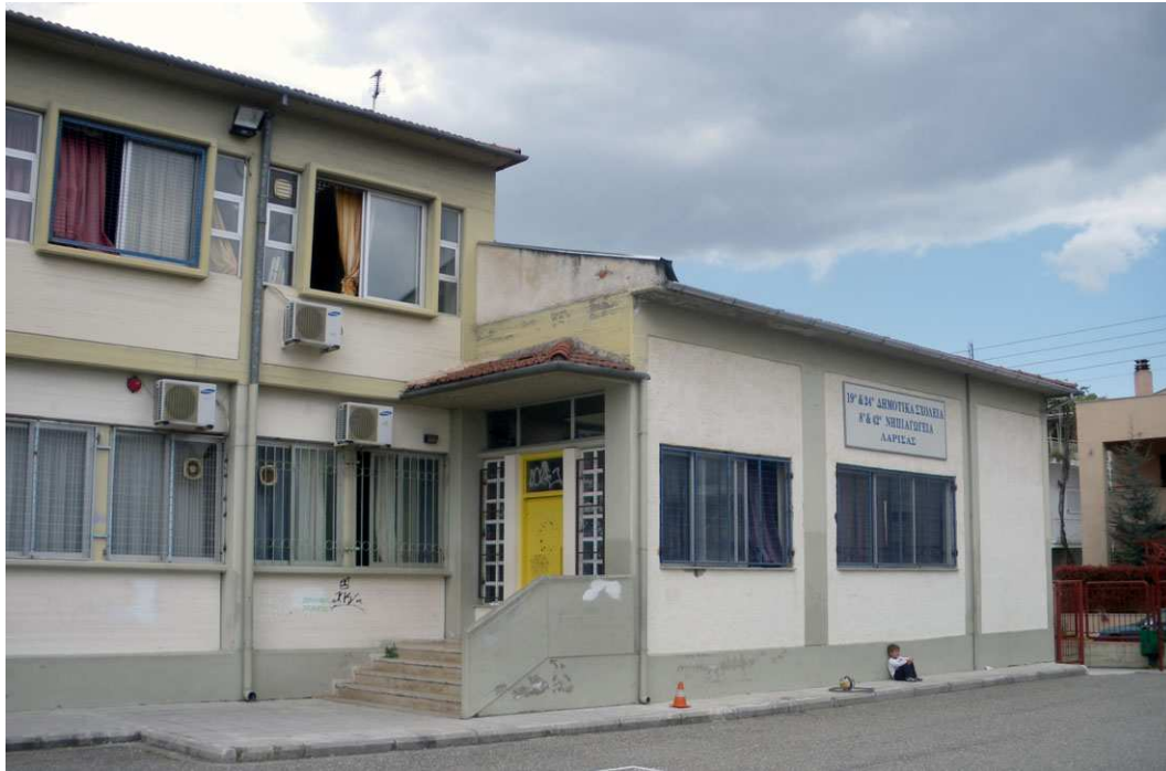
Εικόνα 1: Άποψη του σχολικού κτηρίου.
