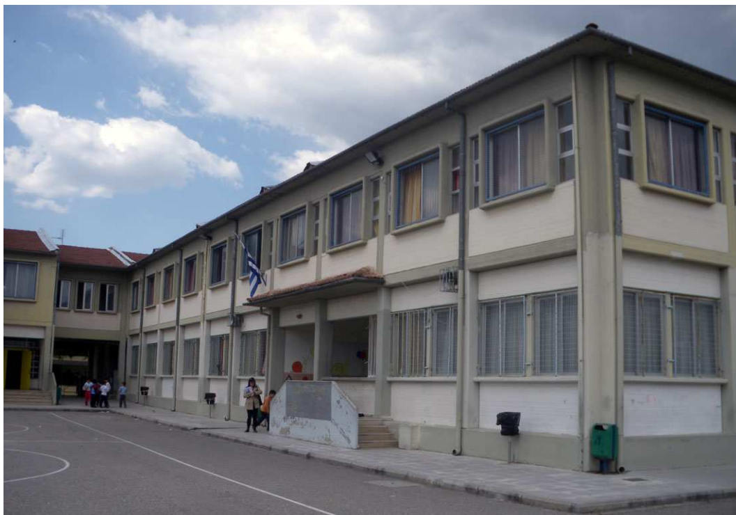
Εικόνα 2: Άποψη του σχολικού κτηρίου.
