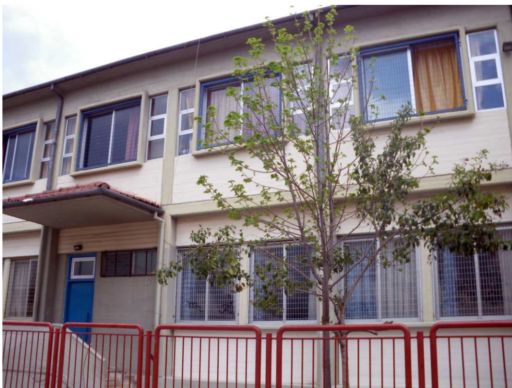
Εικόνα 3: Άποψη του σχολικού κτηρίου.
