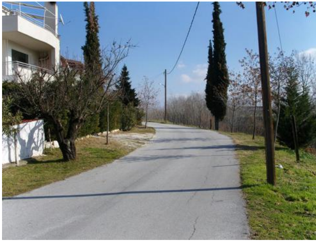
Ασφαλτόστρωση βόρειου αναχώματος
