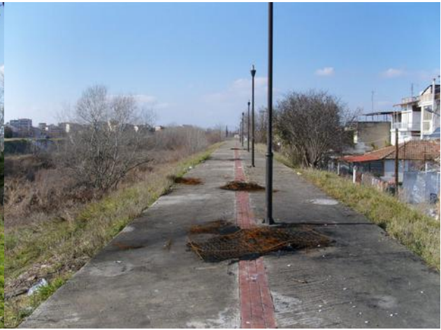
Πεζοδρόμηση βόρειου αναχώματος
