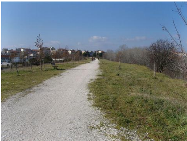
Διάστρωση νότιου αναχώματος
